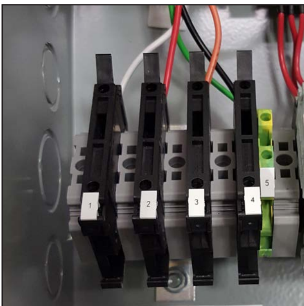
FIGURA 2 Bornes portafusibles de la alimentación del LC6000
