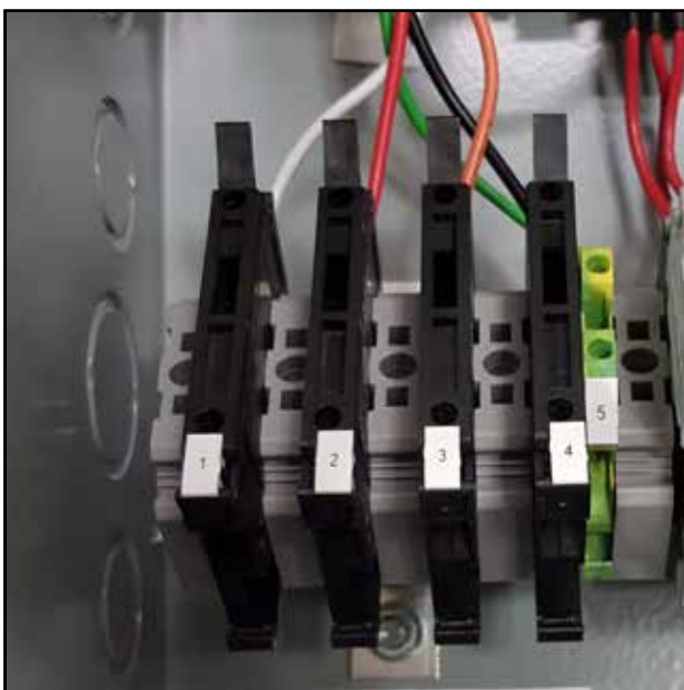
FIGURA 2 Bornes portafusibles de la alimentación del LC6000
