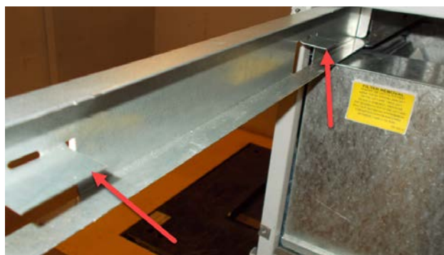
FIGURE 5 Pliage vers le bas des languettes du filtre
