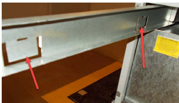
FIGURE 5 Pliage vers le bas des languettes du filtre
